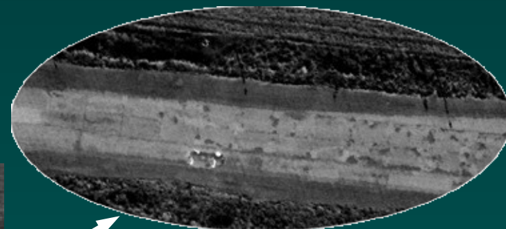
Разрушение дорожного полотна
